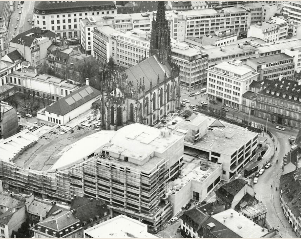
Aus statischen Gründen wird das 2500 m 2 grosse Hängedach des Basler Stadttheaters 1971 ohne Arbeitsfugen betoniert. Für die Betonierdauer von 18 Stunden werden acht Gruppen zu je sieben Männern eingesetzt.
