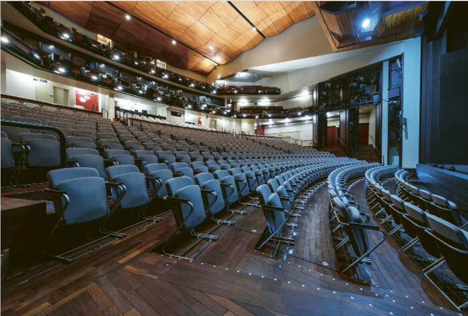
Vorhang auf für die Sanierung der Bodenbeläge im Stadttheater Basel. Beschädigte Stellen des Parketts aus Sucupira – einem Tropenholz – werden durch Akazie ersetzt. Hierfür müssen beide Hölzer auf einen Farbton angeglichen werden.
