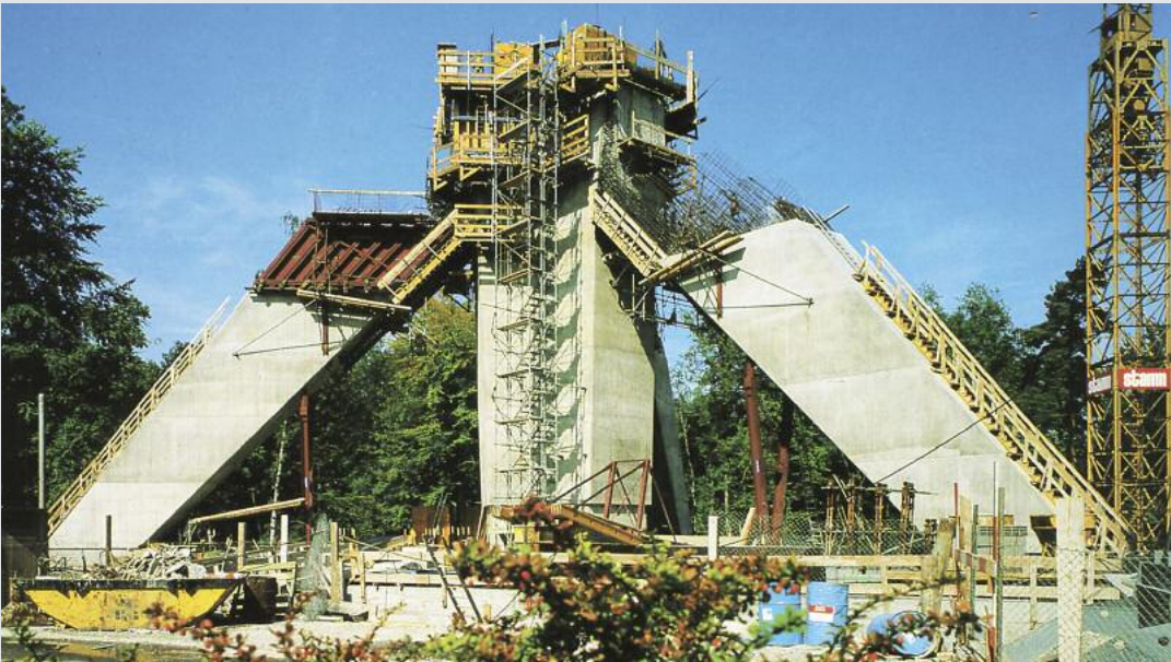
Beim Bau des Fernsehturms und Mehrzweckgebäudes St. Chrischona (1980–83) werden aus Termingründen die Stiele nachträglich an den Schaft angeschlossen. Hierfür wird eine Freivorbauschalung gewählt.
