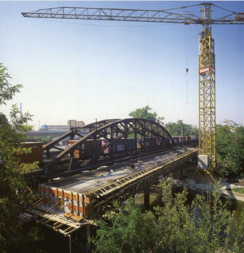
1985 wird die neue Wiesenbrücke inklusive Stützen, Widerlager und Verschiebebahnen in Arbeitsgemeinschaft erstellt. Anfang November kann der Betrieb dann von der Hohlkastenbrücke übernommen werden.
