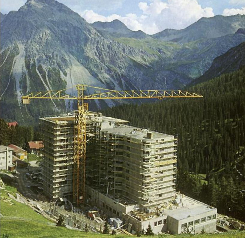
Der anspruchsvolle Wiederaufbau des Tschuggen Grand Hotel in Arosa erfolgt ab 1968 im Stamm-Schüttbauverfahren. Das gesamte Anwesen war 1966 durch einen Grossbrand zerstört worden.
