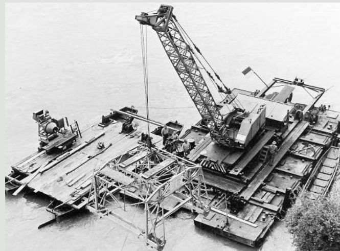
Probleme durch die engen Zufahrtsverhältnisse beim Umbau der Zoologischen Anstalt im alten Kollegiengebäude der Universität löst Ulrich Stamm 1959 durch eine Materialanlieferung auf dem Wasserweg.
