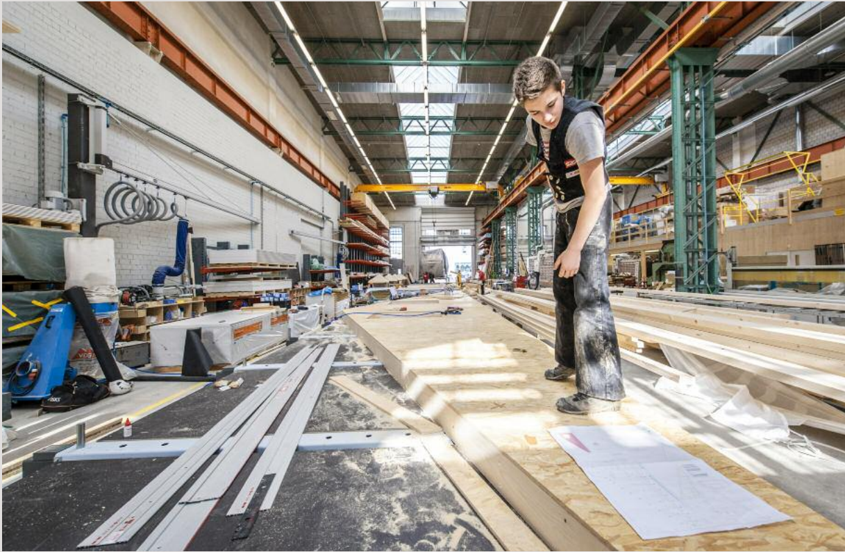
Nicht nur dem Holz- und Modulbau bieten die Werkhallen in Arlesheim den nötigen Raum, um grosse Bauelemente herzustellen. Die hier vorgefertigten Wand-, Decken- und Dachelemente verkürzen die Arbeitszeiten auf der Baustelle.
