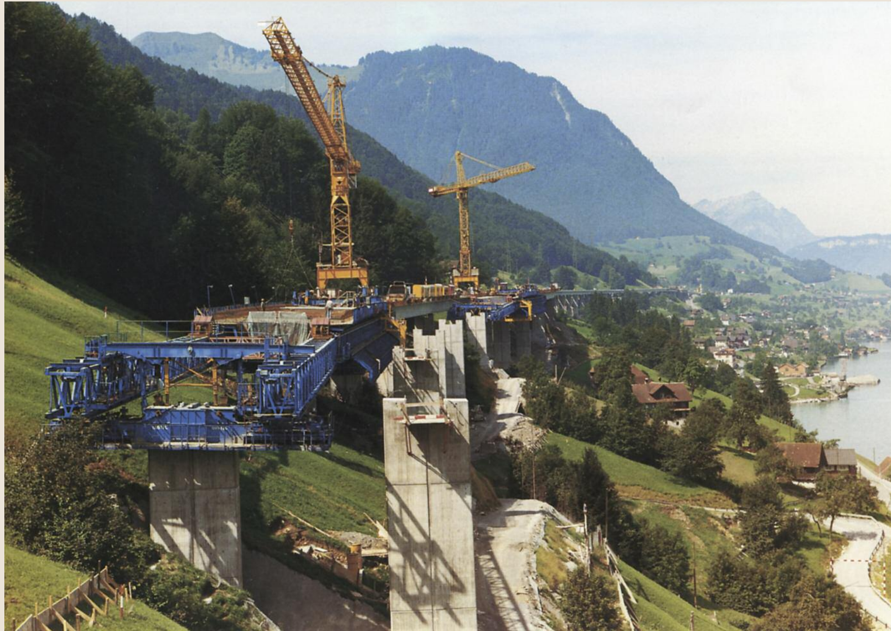
Das Bild zeigt das Lehnenviadukt Beckenried im Mai 1980 mit Blick vom Portal des Seeligbertunnels. Gut viereinhalb Jahre dauert der Bau, an dem Stamm in einer Arbeitsgemeinschaft mitwirken kann.
