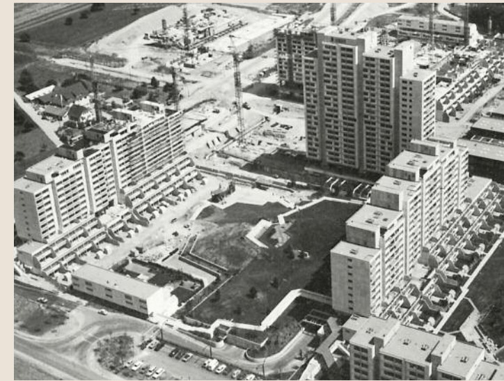
Bei der Bauausführung der Wohnsiedlung Liebrüti für den Pharmakonzern Hoffman-La Roche wird 1974 vor Ort eine Filigrananlage errichtet, mit der sich Deckenplatten in Zimmergrösse anfertigen lassen. Hierdurch entfallen die Fugenbehandlung und die Anlieferungskosten.
