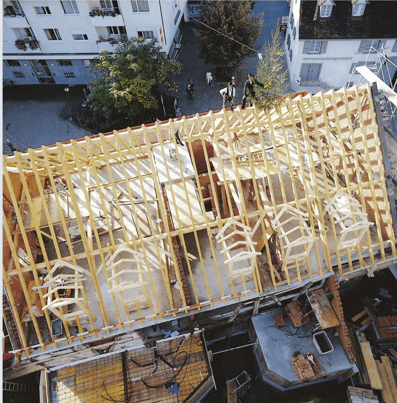
Die Zimmerei erstellt für das unter Denkmalschutz stehende Bauernhaus an der Rössligasse in Riehen einen neuen Dachstuhl.
