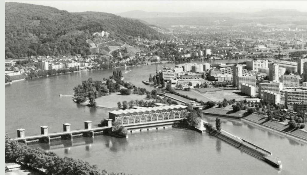
1952 ist die Firma Stamm beim Bau des Kraftwerks Birsfelden in einer Arbeitsgemeinschaft für die Kiesaufbereitung verantwortlich.
