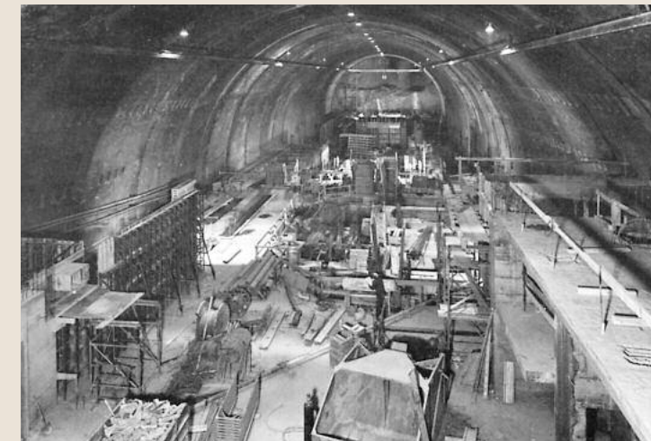
Am Bau des Umwälzwerks am Grimselpass (1973–80) kann Stamm in der Arbeitsgemeinschaft seine Erfahrungen im Eisenbetonbau einbringen. Unter grossem Einsatz von Personal und Inventar werden dabei etwa 12 000 m 3 Beton im Berginneren verarbeitet.
